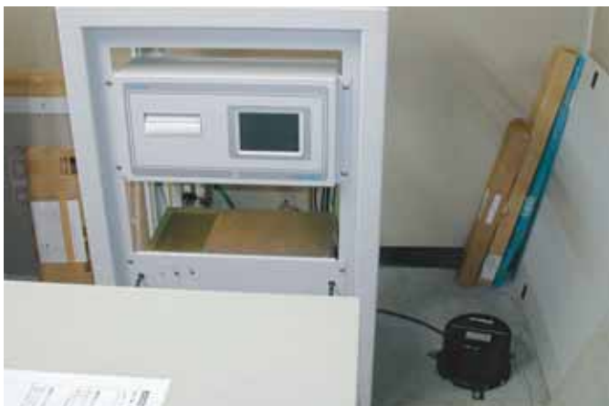
写真1 斜里町役場1階に設置されている地震計(右下)
