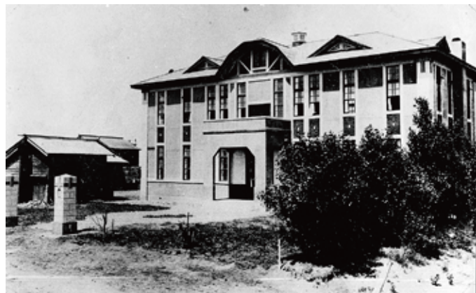
写真1 旧役場庁舎(昭和4年 新築落成時)
